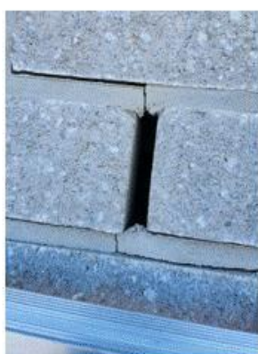
Mur creux (isolant de 4cm)
