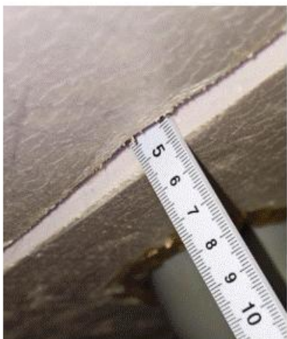
Isolant (5cm) toiture garage
