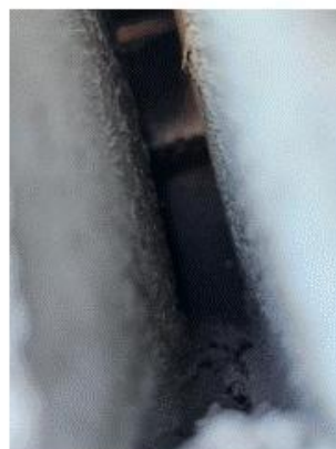
Mur creux (isolant de 4cm)
