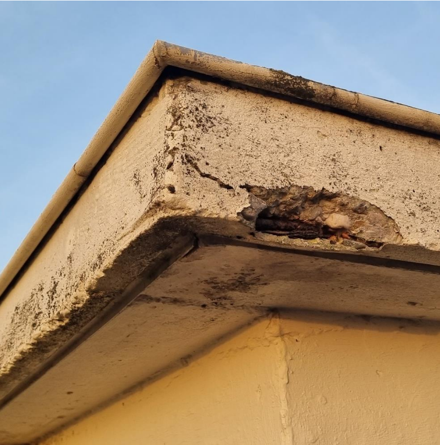
Casquette cabanon – éclatement du béton et rouille des armatures
