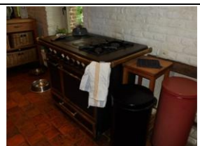
Photo n° PhGaz001 Localisation : Séjour Cuisinière Godin (Type : Non raccordé) Localisation sur croquis : 001
