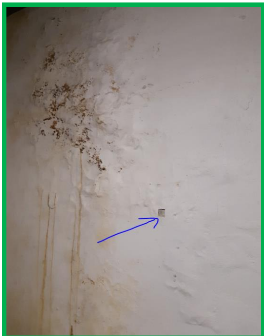
Figuur 8: Pleisterbezetting van de muren in de stookruimte in de kelder: geen asbest.
