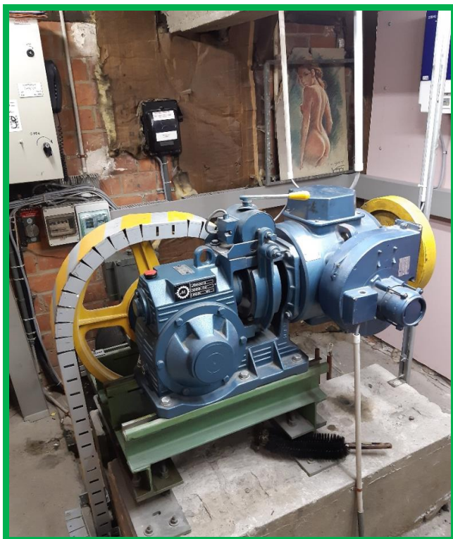
Figuur 3: Liftmachinekamer (zie ook attest in bijlage 8.6): geen asbest.
