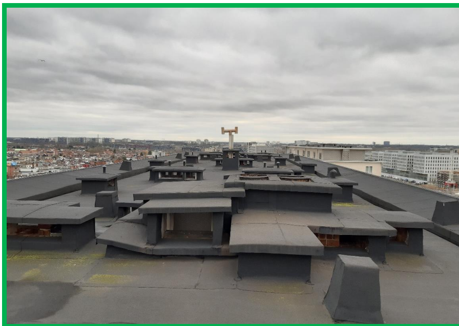
Figuur 13: Roofing op het dak onlangs vernieuwd: geen asbest. Uitstekende buizen geen cement: geen asbest.
