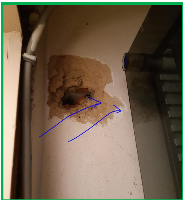
Figuur 4: Pleisterbezetting aan de muren in de traphal, 2 lagen (bruin en wit): geen asbest.
