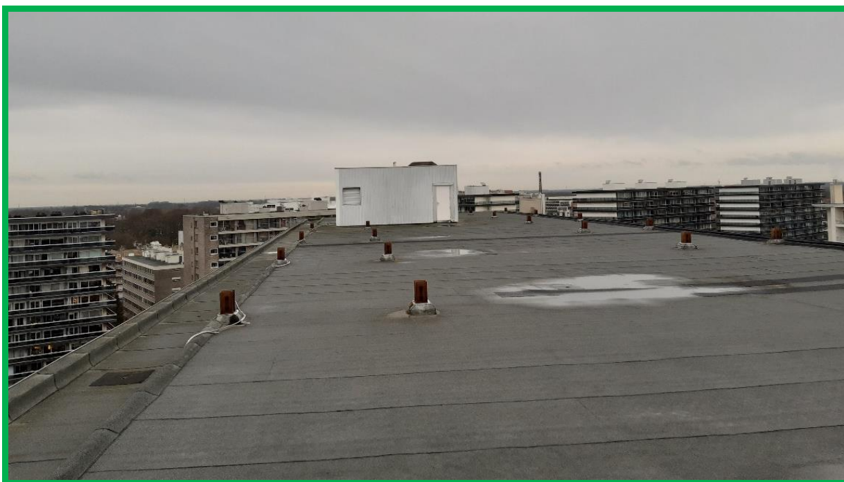
Figuur 4: roofing, op sommige plaatsen vernieuwd: geen asbest
