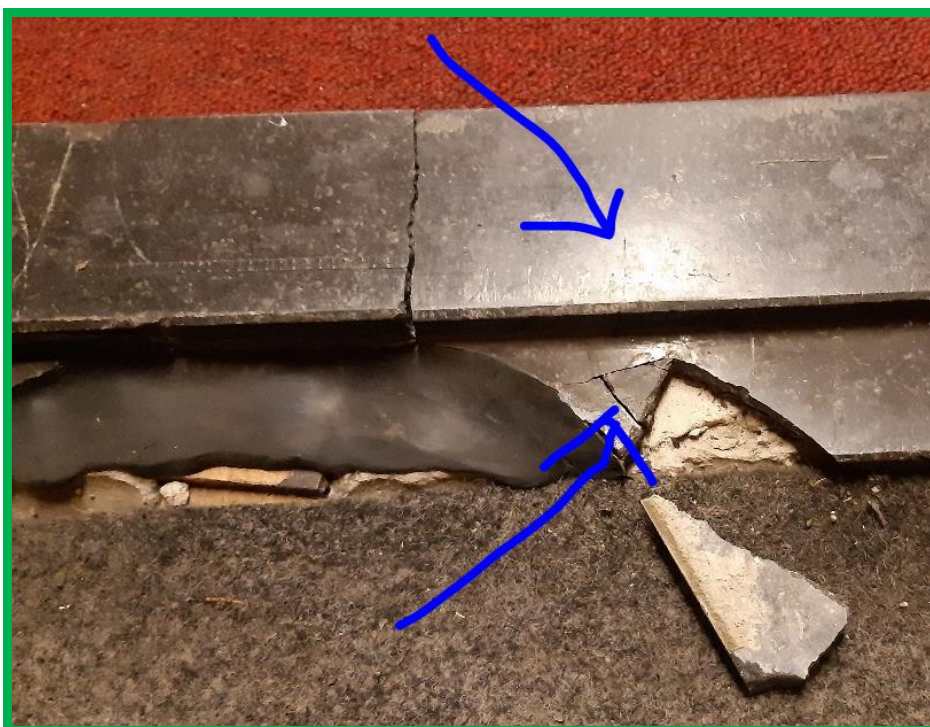
Figuur 6: op alle verdiepingen van de appartementen: drempels in de deuropeningen: geen asbest.
