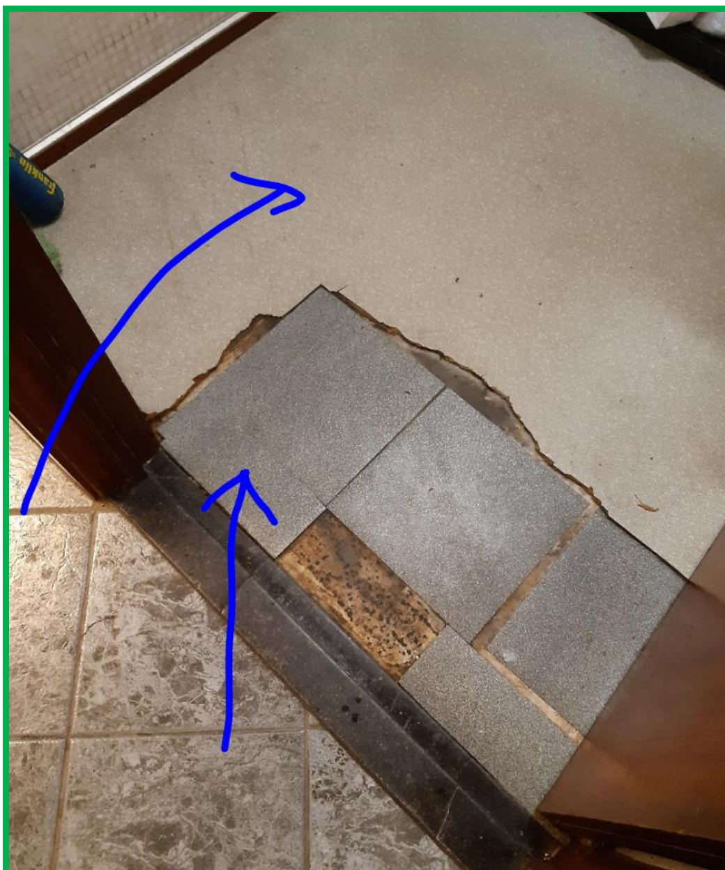
Figuur 8: Gelijkvloers, conciërgelokaal: witte linoleum vloer en grijze vinyltegels: geen asbest.
