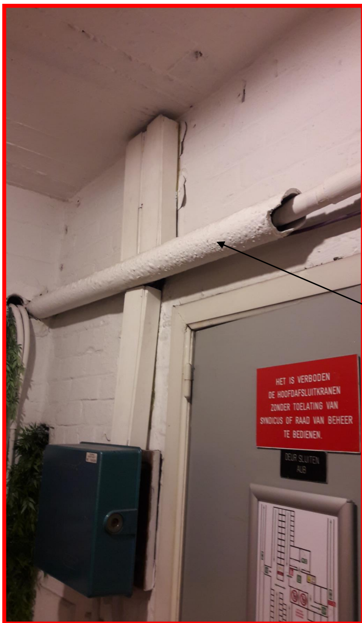
Figuur 4: Cementbuis rond leiding in de kelder, tegenover de lift: asbest aanwezig.
