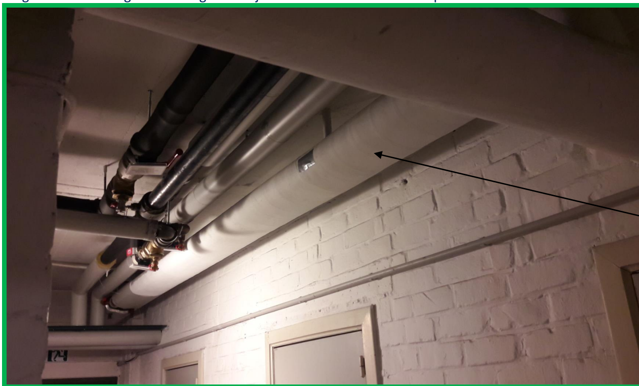
Figuur 3: Buisisolatie in de kelder: geen asbest aanwezig.
