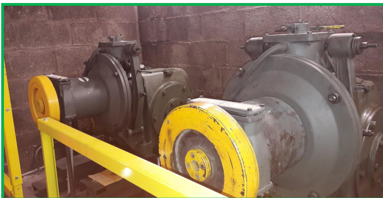
Figuur 8: Liftmachinekamer: geen asbest (zie attest van regularisatie in bijlage).
