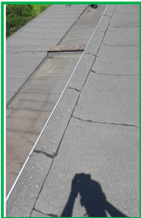
Figuur 11: Roofing, vernieuwd in 2013: geen asbest aanwezig
