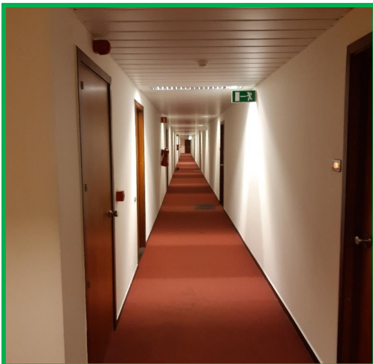
Figuur 7: Gangen, allemaal gelijkaardig (behalve gelijkvloers) ongeveer 7 jaar geleden vernieuwd: plafondlamellen en tapijttegels: geen asbest.
