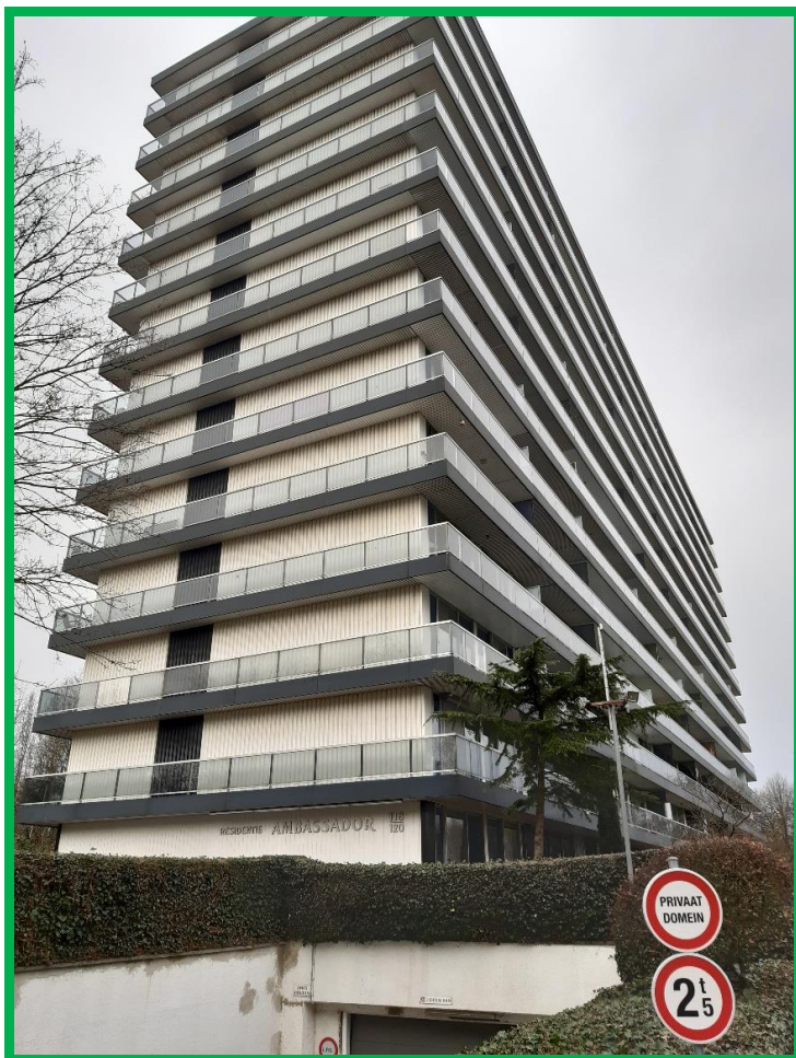
Figuur 3: Buitenkant van het gebouw: geen asbest zichtbaar.
