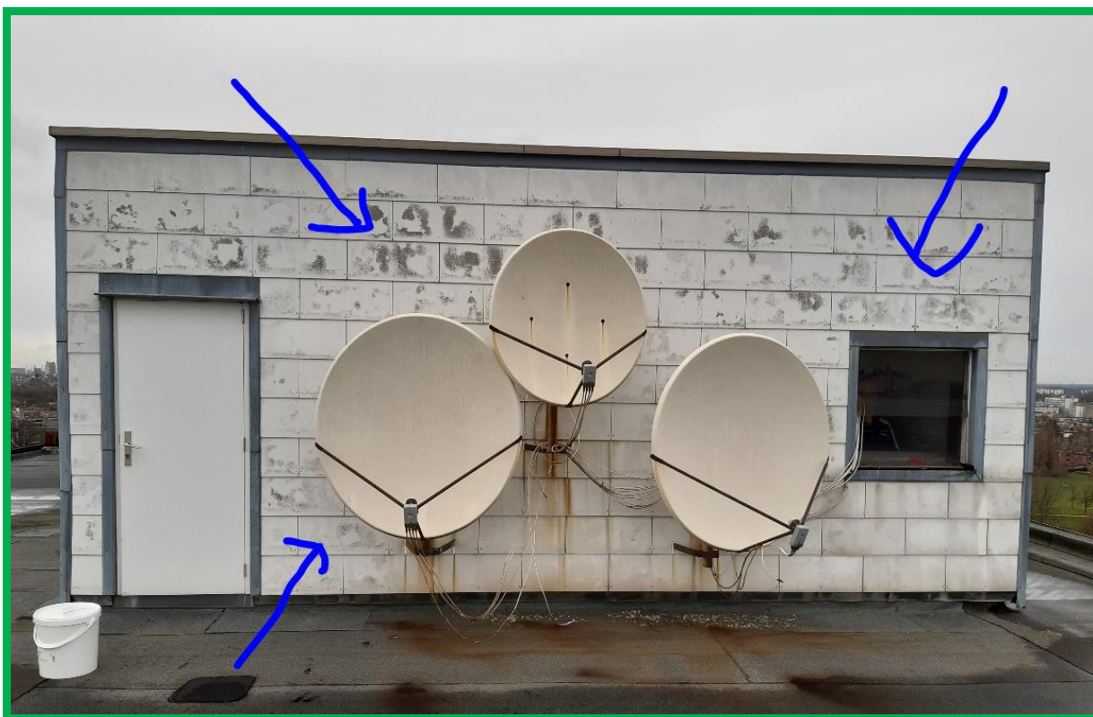
Figuur 5: 1 muur met leien tegen de gevel op het dak: geen asbest.
