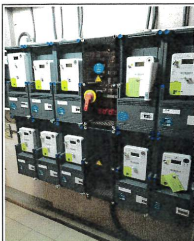
Foto 14: Elektricietsmeters
