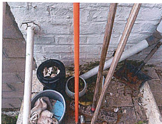
Descente pluviale de la petite toiture de la terrasse qui déverse ses eaux au sommet de l'escalier.
