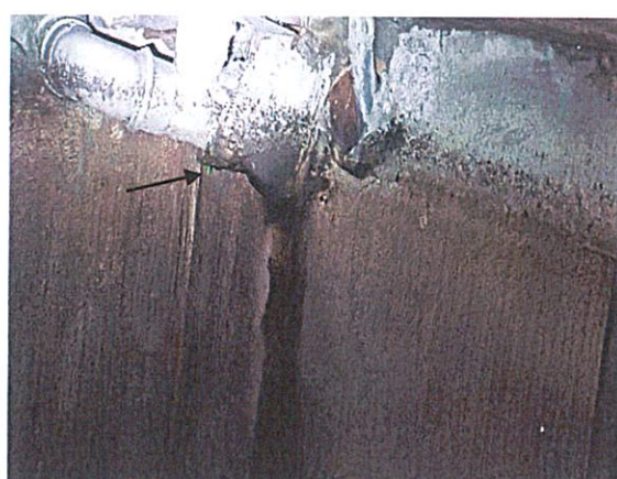
A l'intérieur de la citerne d'eau de pluie, fuite détectée sur la décharge qui reprend les eaux fécales.
