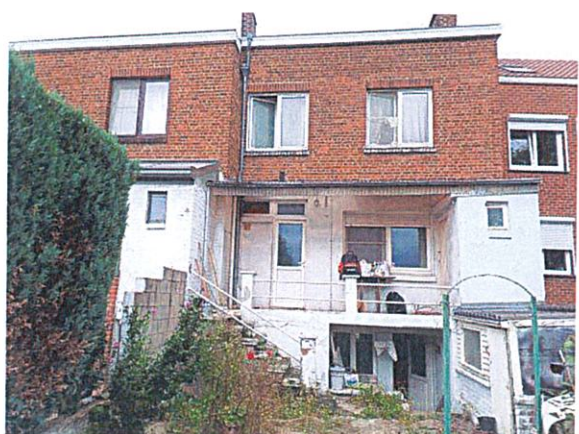
Vue de la terrasse de l'habitation de Mme Sablink.
