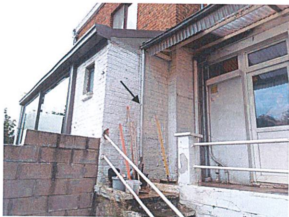
Descente pluviale de la petite toiture de la terrasse qui déverse ses eaux au sommet de l'escalier.
