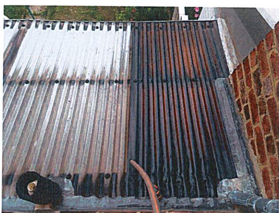
Recherche à l'eau réalisée au départ de la petite toiture de la terrasse.
