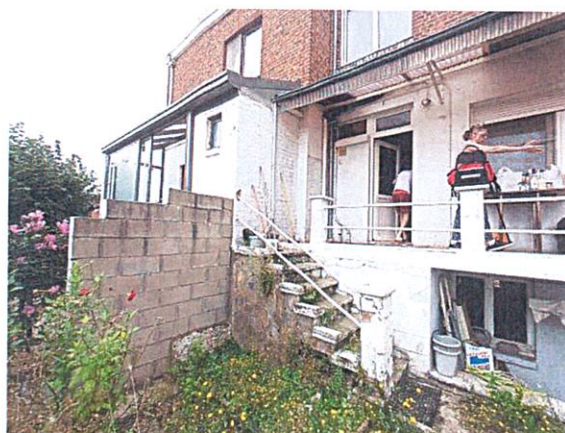
Escalier qui est adossé aux toilettes de la véranda.
