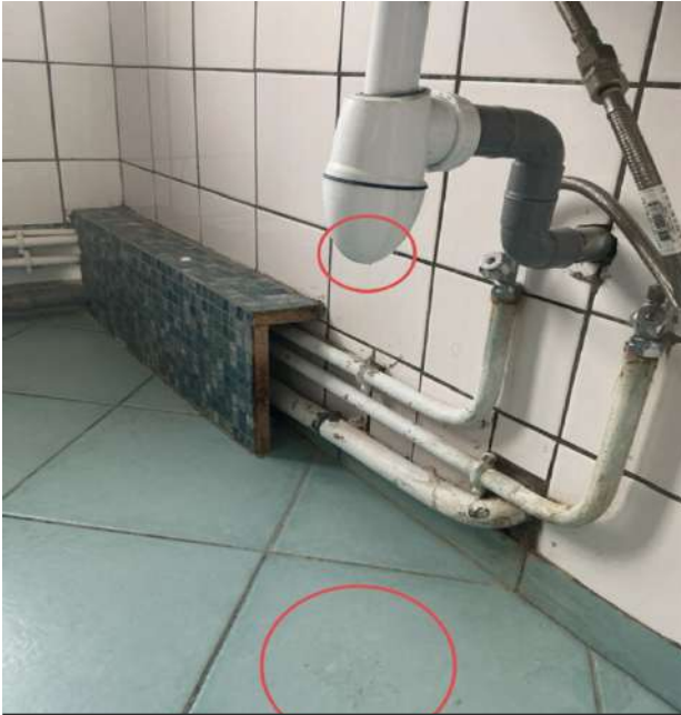
Photo 247 • Salle de bains / Lavabo
