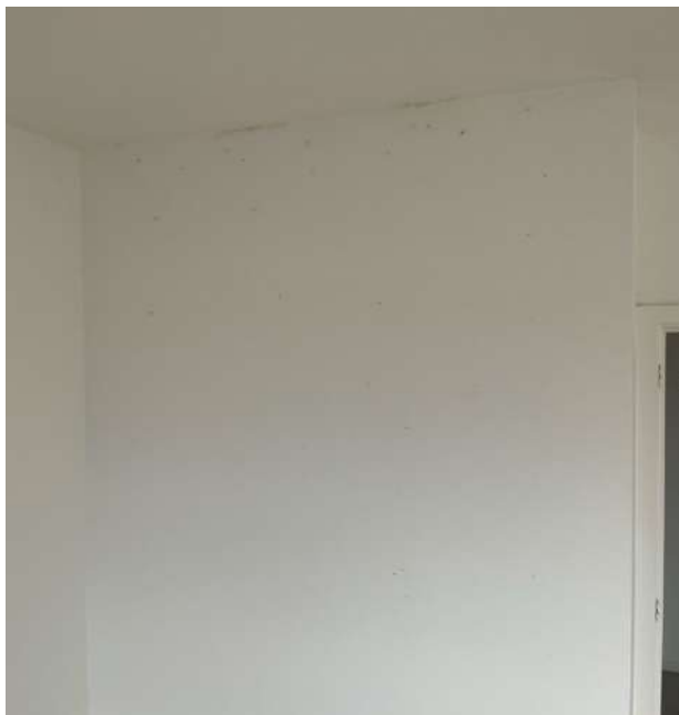
Photo 107 • Salle à manger / séjour / Mur
