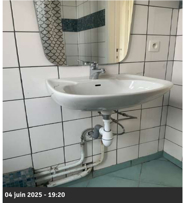
Photo 233 • Salle de bains / Mur
