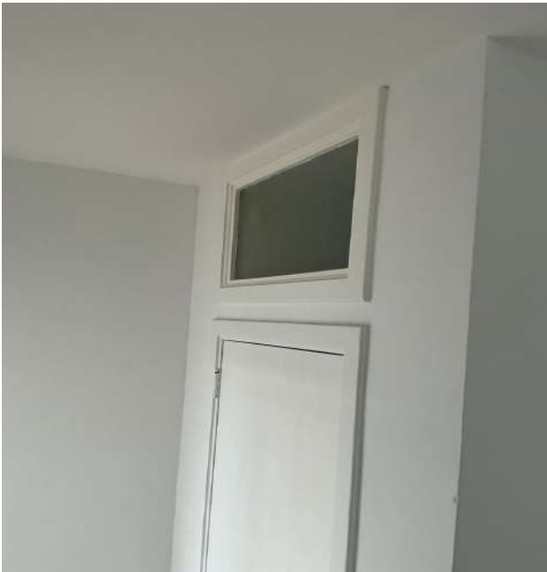
Photo 147 • Hall de nuit / Mur
