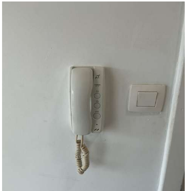
Photo 92 • Hall d'entrée / Interphone
