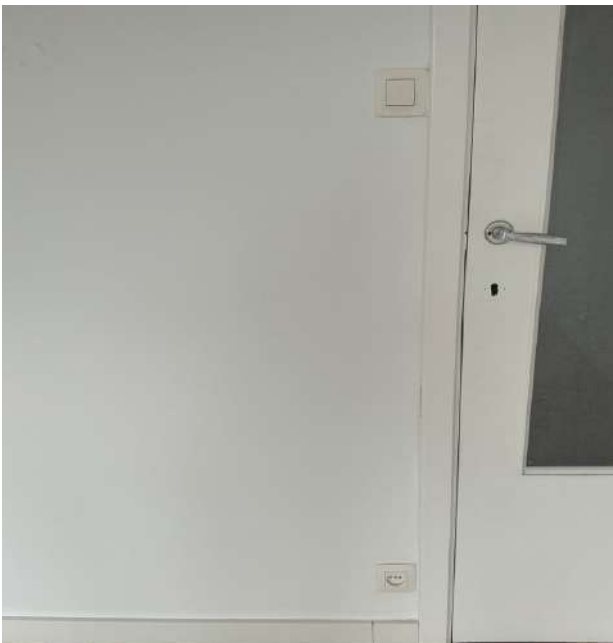
Photo 139 • Salle à manger / séjour / Interrupteur / prise
