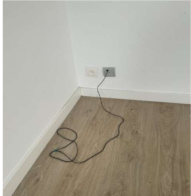
Photo 138 • Salle à manger / séjour / Interrupteur / prise
