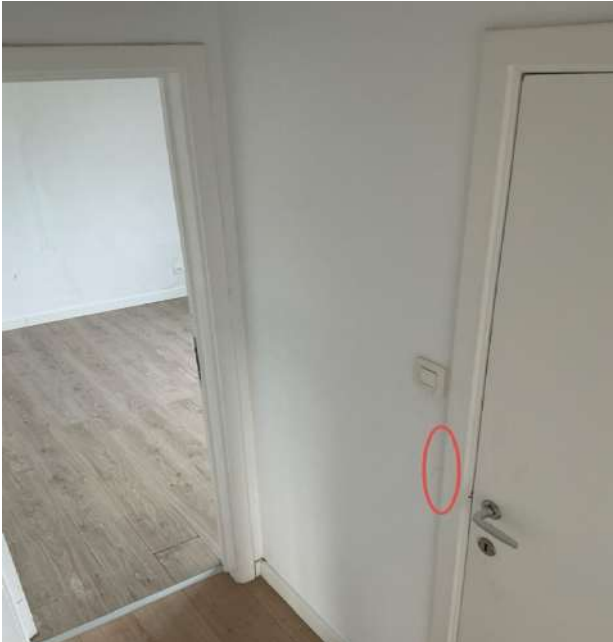
Photo 152 • Hall de nuit / Mur
