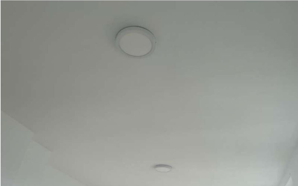
Photo 124 • Salle à manger / séjour / Plafond
