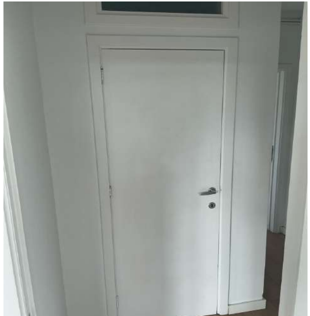
Photo 148 • Hall de nuit / Mur
