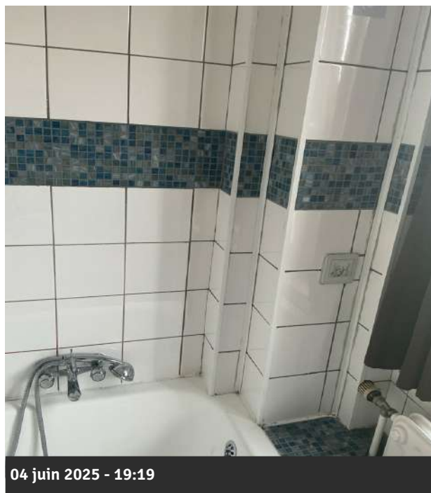
Photo 227 • Salle de bains / Mur
