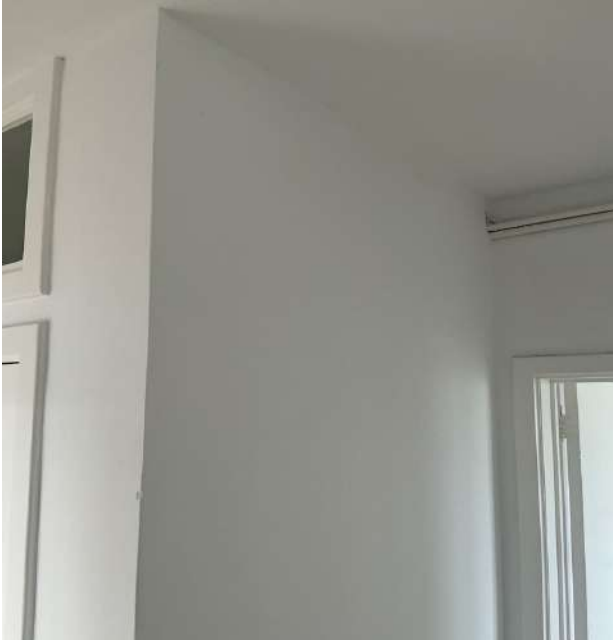
Photo 149 • Hall de nuit / Mur
