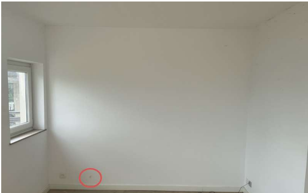
Photo 117 • Salle à manger / séjour / Mur
