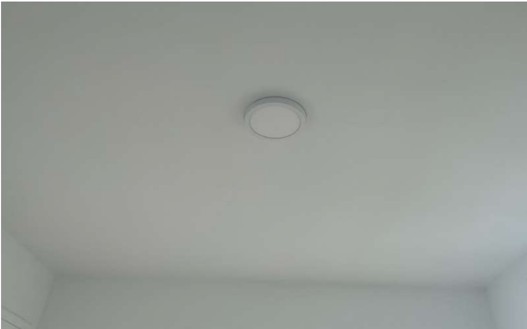
Photo 125 • Salle à manger / séjour / Plafond
