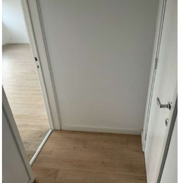
Photo 146 • Hall de nuit / Mur
