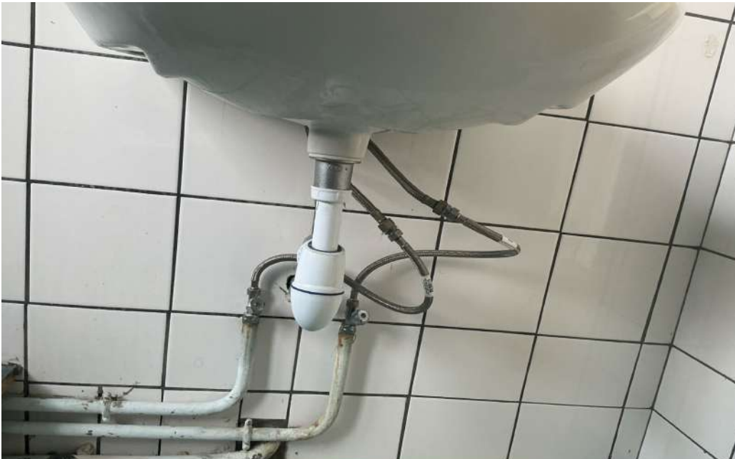
Photo 246 • Salle de bains / Lavabo
