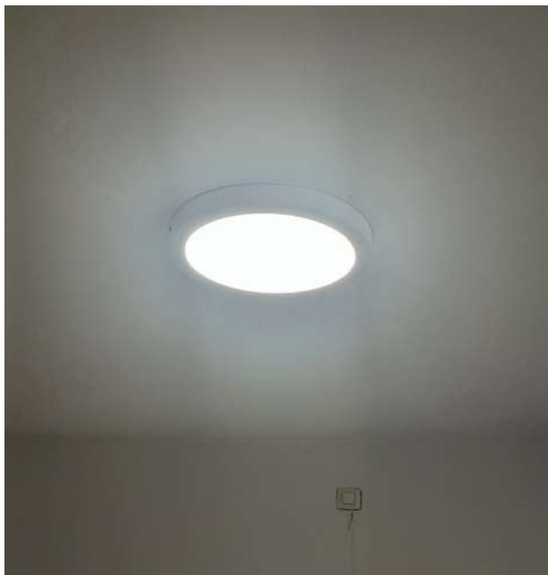
Photo 278 • Chambre / Point lumineux
