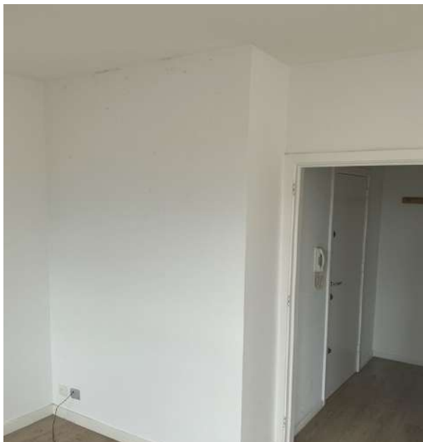
Photo 106 • Salle à manger / séjour / Mur
