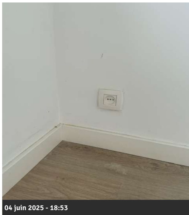
Photo 142 • Salle à manger / séjour / Interrupteur / prise
