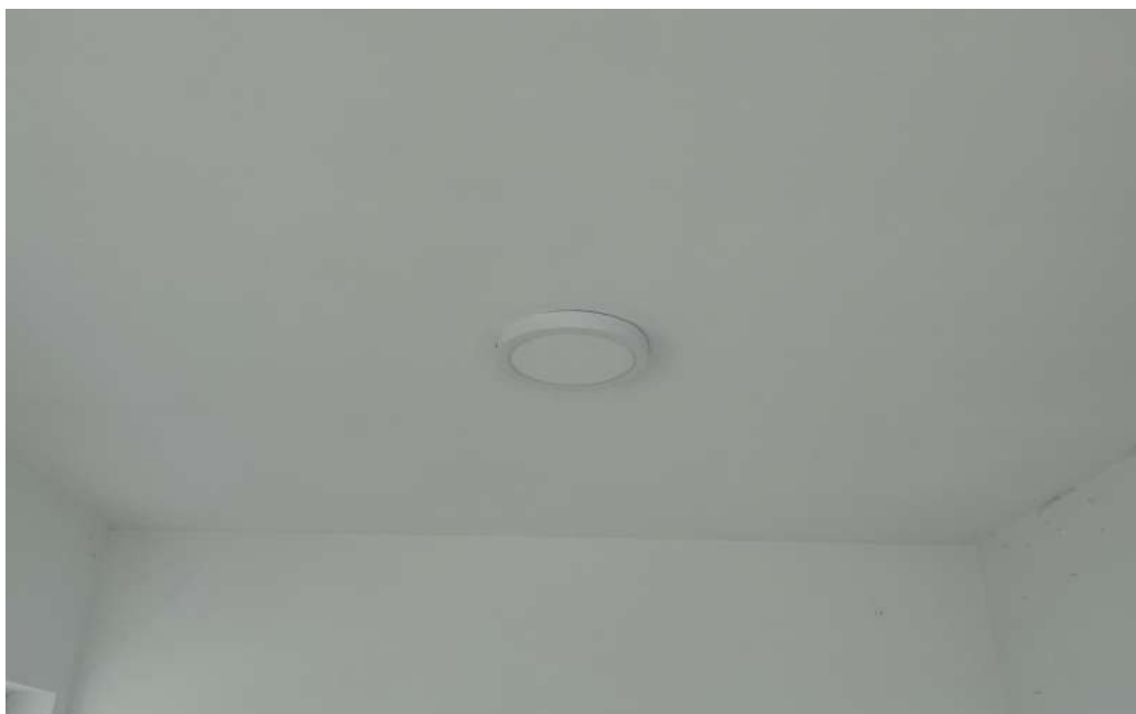
Photo 123 • Salle à manger / séjour / Plafond
