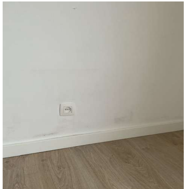
Photo 284 • Chambre / Interrupteur / prise
