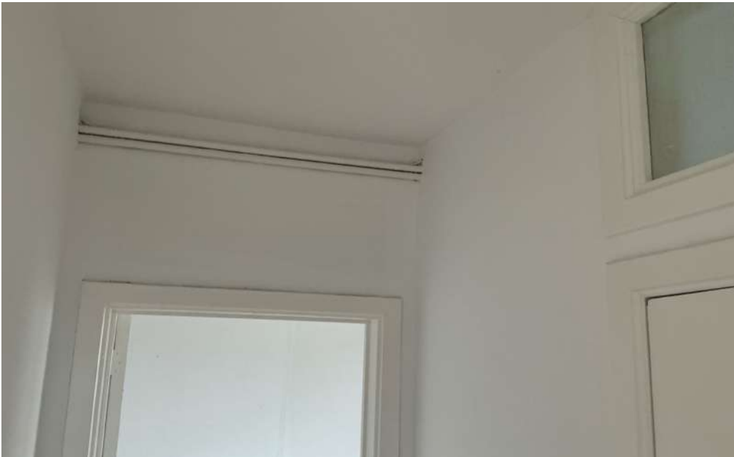
Photo 151 • Hall de nuit / Mur
