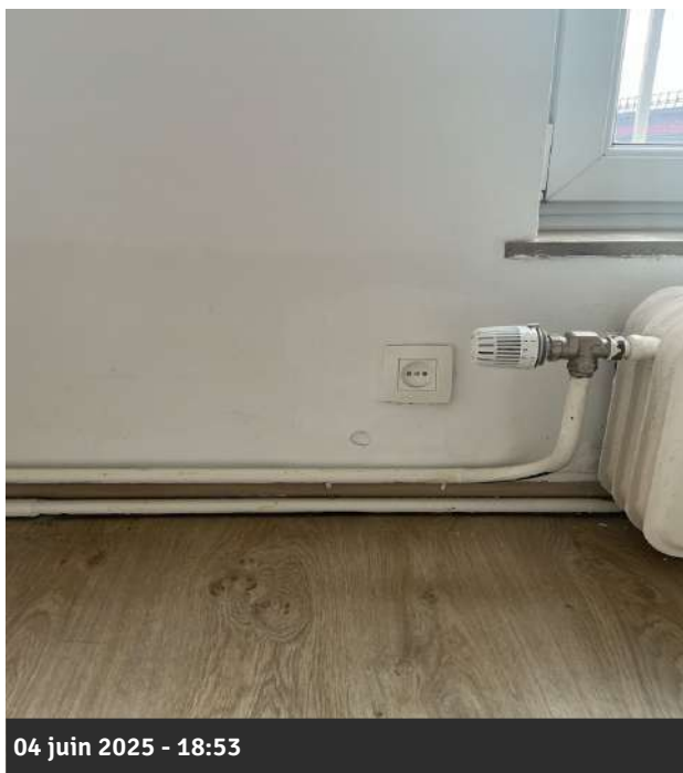
Photo 141 • Salle à manger / séjour / Interrupteur / prise
