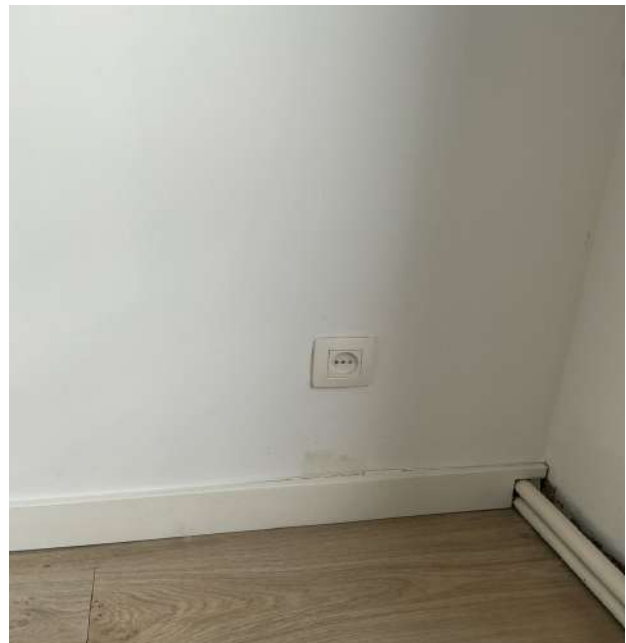
Photo 140 • Salle à manger / séjour / Interrupteur / prise
