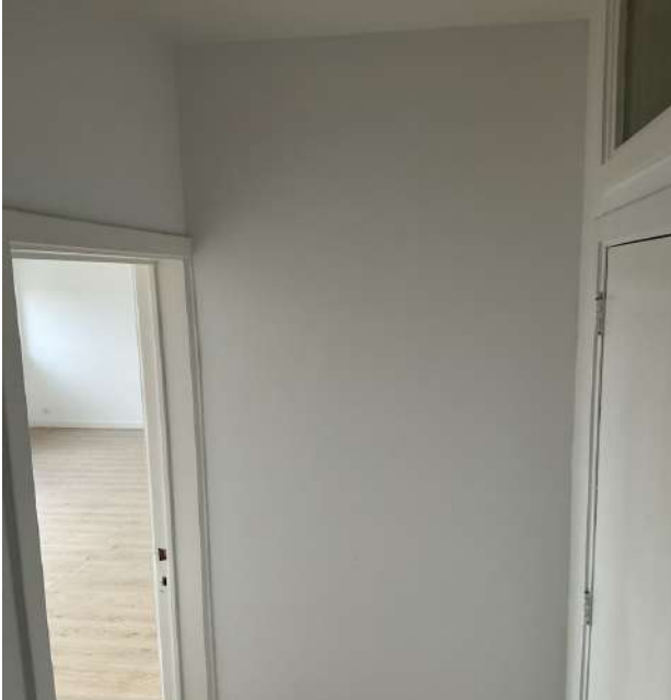
Photo 145 • Hall de nuit / Mur
