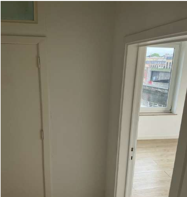
Photo 154 • Hall de nuit / Mur
