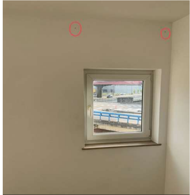
Photo 116 • Salle à manger / séjour / Mur
