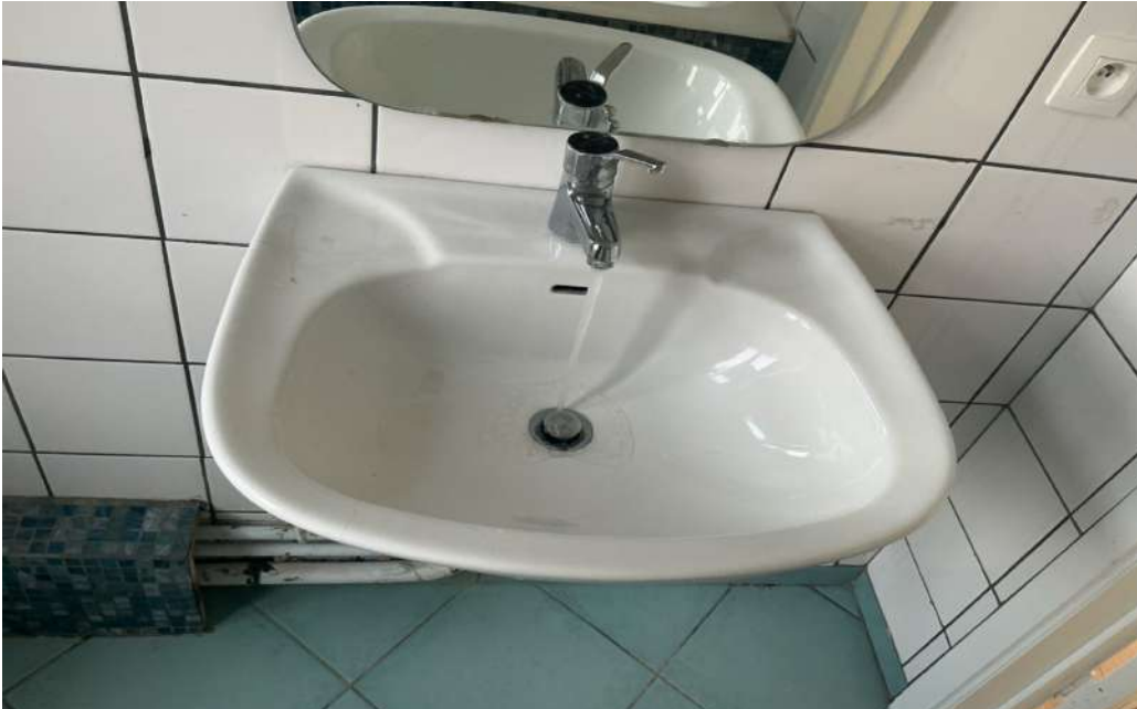
Photo 245 • Salle de bains / Lavabo
