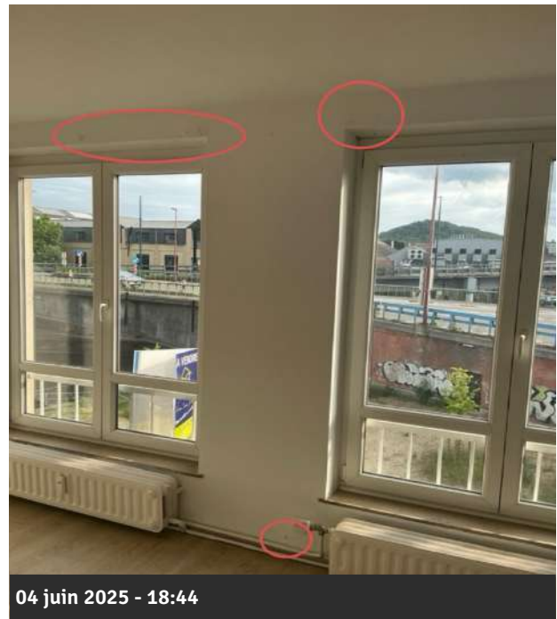
Photo 114 • Salle à manger / séjour / Mur
