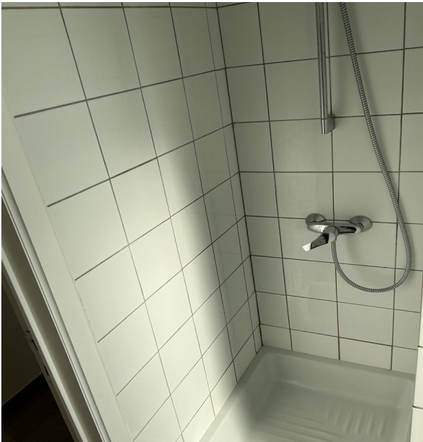
Photo 73 • Salle de bains / Mur
