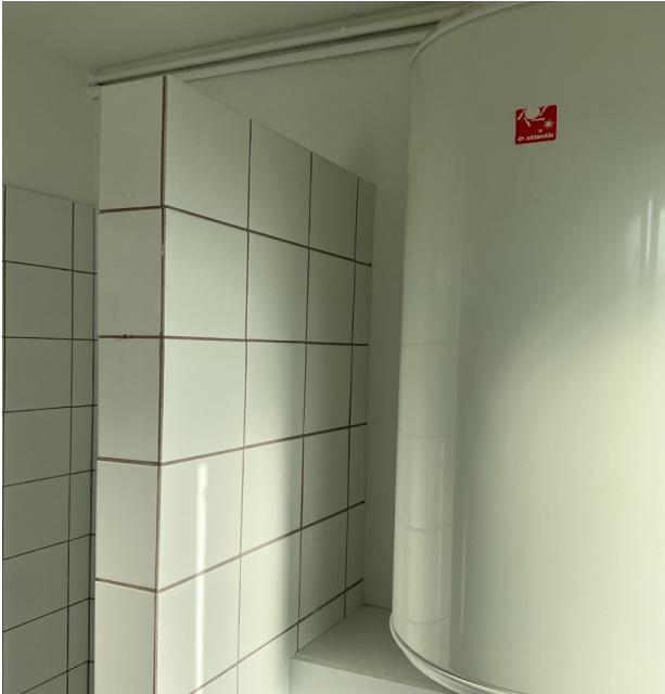
Photo 71 • Salle de bains / Mur
