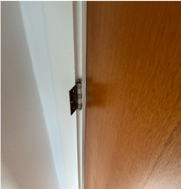
Photo 43 • Chambre en face du pont / Porte
