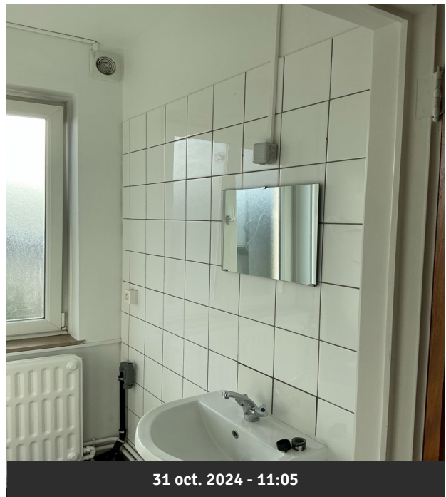
Photo 68 • Salle de bains / Mur
