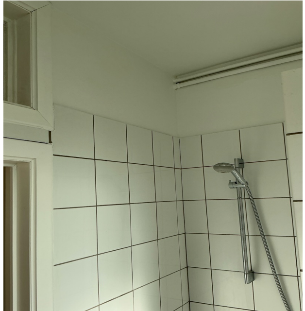
Photo 72 • Salle de bains / Mur
