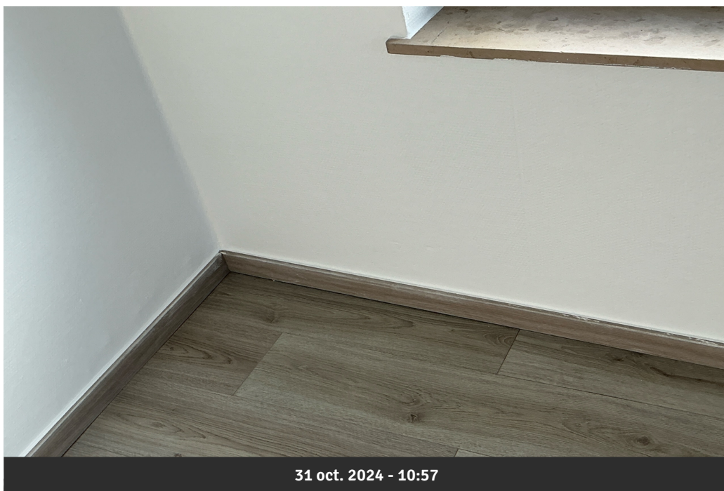
Photo 40 • Chambre en face du pont / Plinthe
