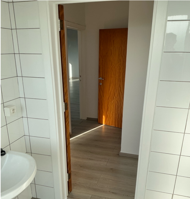
Photo 77 • Salle de bains / Mur
