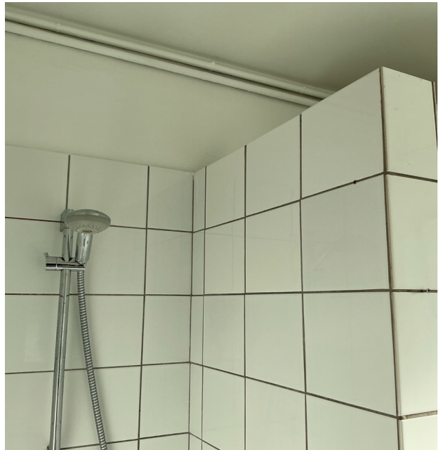
Photo 74 • Salle de bains / Mur
