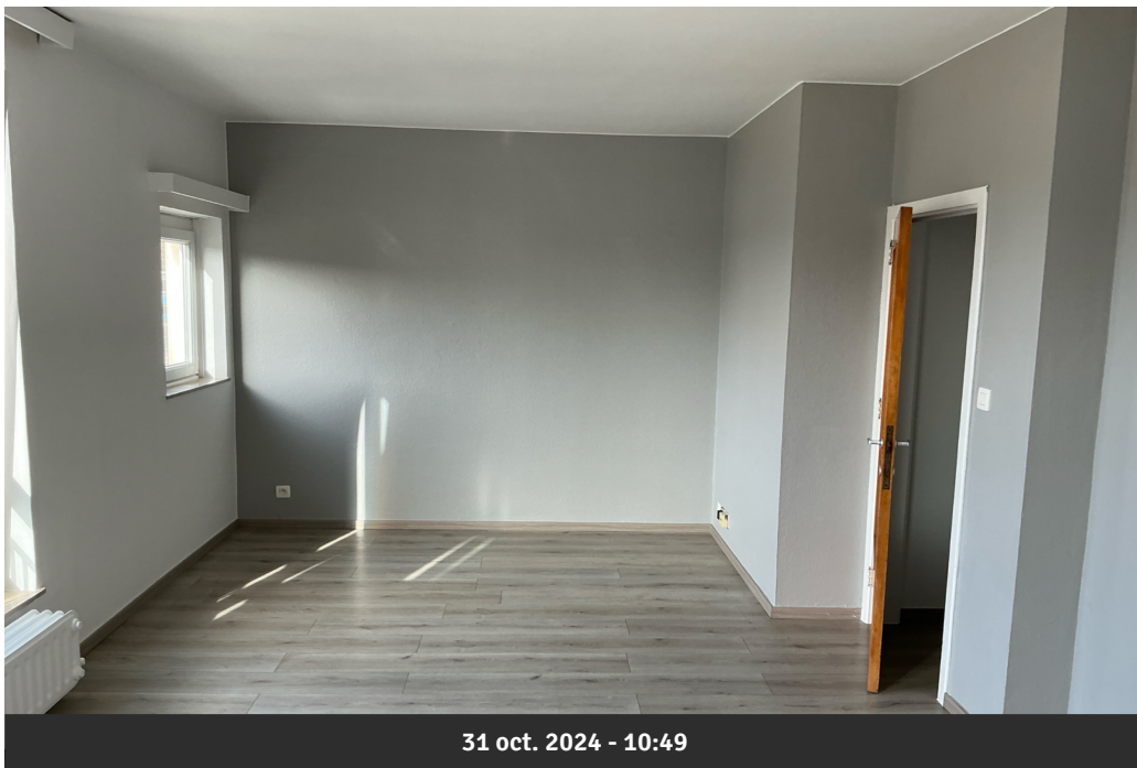
Photo 8 • Salle à manger + séjour / Mur
