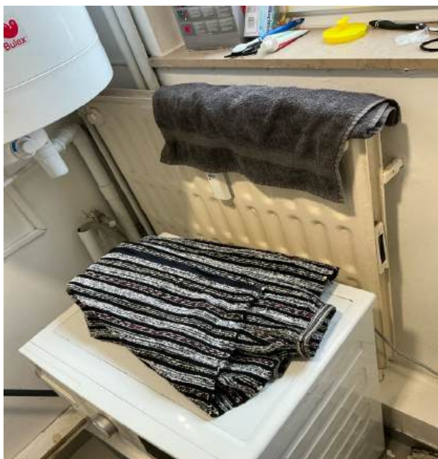
Photo 165 • Salle de bains / Radiateur
