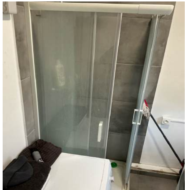
Photo 152 • Salle de bains / Mur
