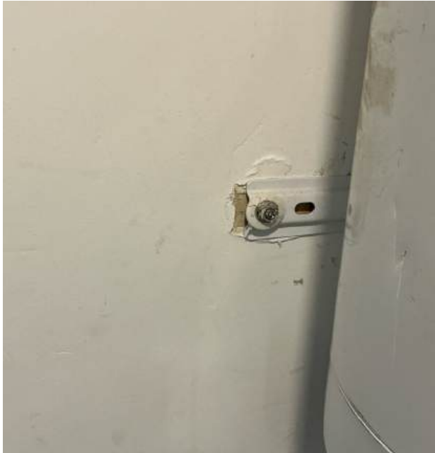
Photo 149 • Salle de bains / Mur
