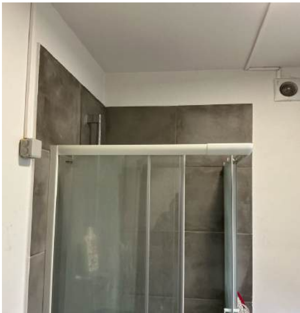
Photo 151 • Salle de bains / Mur
