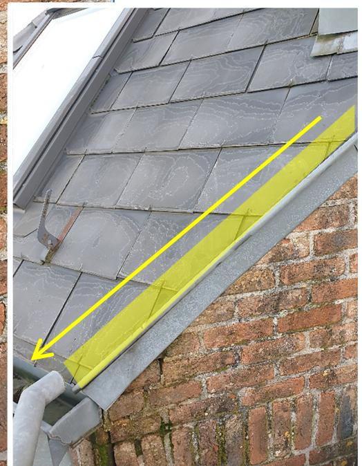
**Érosion puis disparition des joints ciment. Formation de mousses.**
