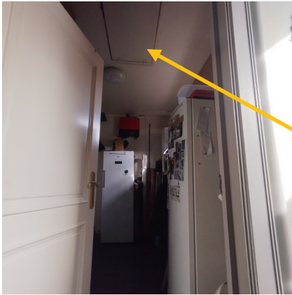
Toegang via cv-ruimte
