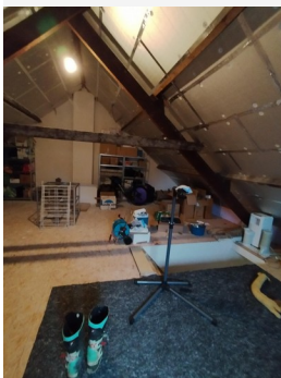
Onderdak Zolder is afgewerkt met isolatiemateriaal.
