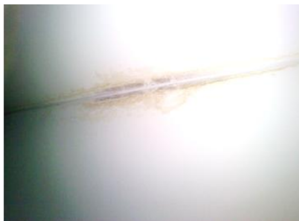
Clichés IR visibles n°6 : local dénommé bureau sur le plan Observation : zone froide localisée sur zone de brunissement de paroi
