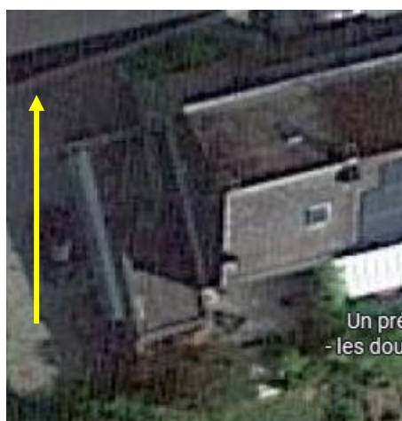
Photo n°2 : vue aérienne bâtiment (source : google maps)
