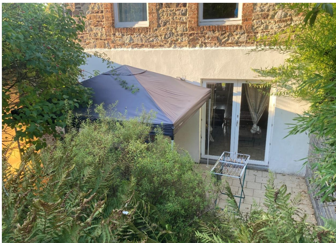
Photo n°3 : vue sur façade arrière (sud)
