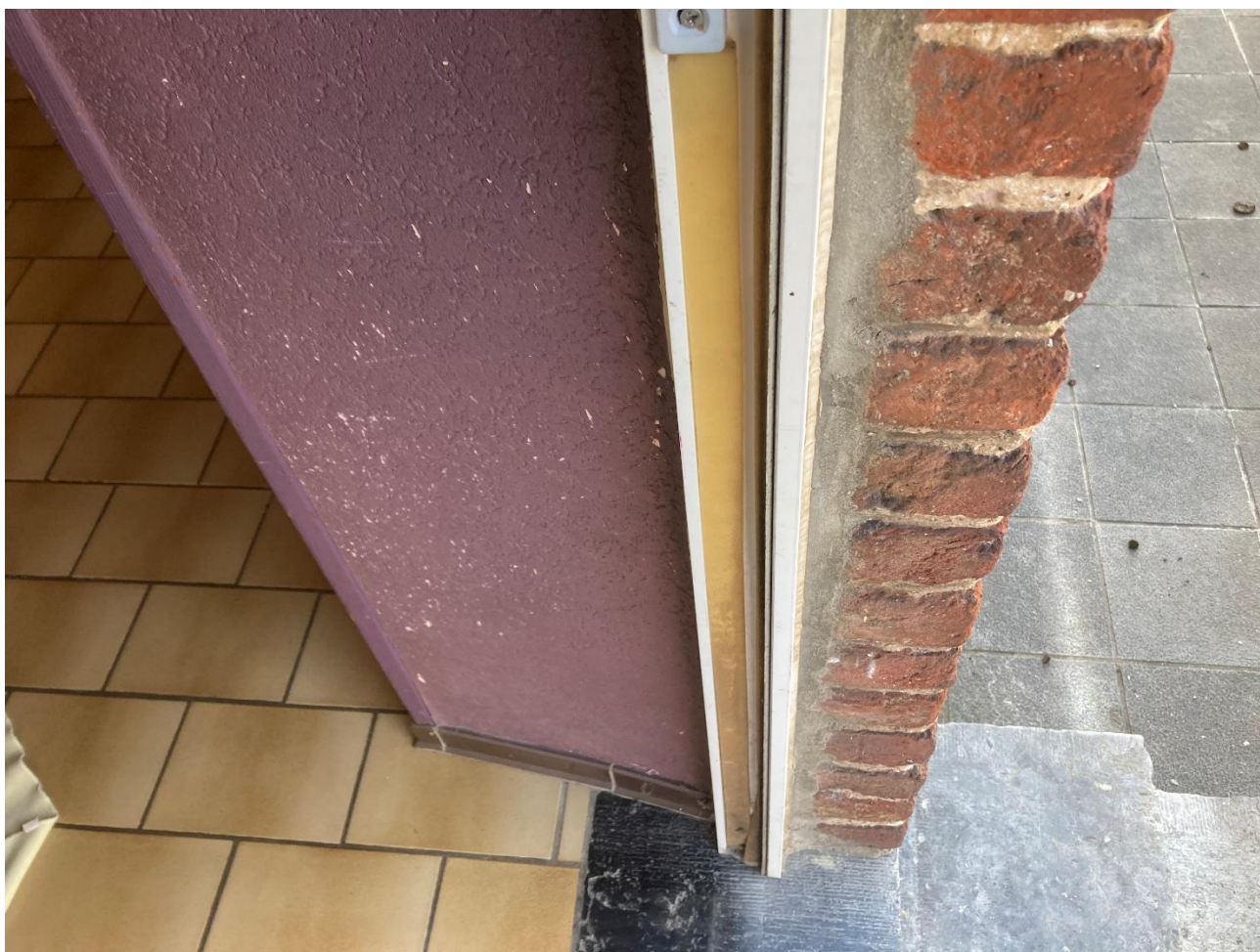
Photo n°7 : vue sur mur au niveau de la porte d'entrée
