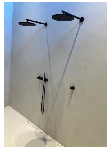
Voorbeeld Mortex afwerking
