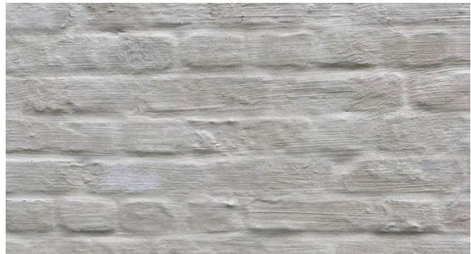
Voorbeeld gekaleide gevel
