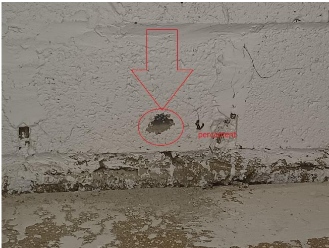
Isolation creux du mur :
