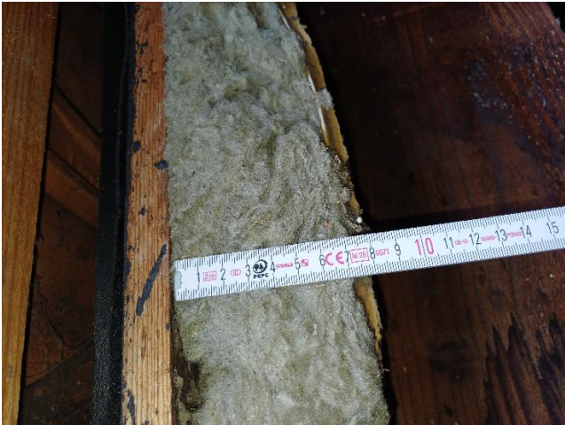
Isolation plafond (plancher grenier)
