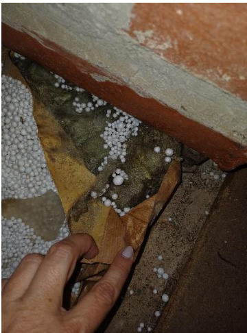
Isolation plafond (plancher grenier)
