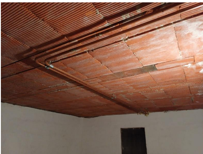
Plancher du rez en terre cuite
