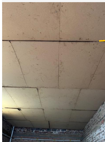
Afwerking binnenkant dak met vezelplaten
