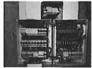
Dispositifs à courant différentiel installés: 4P 63 A 30 mA type A, circuit (s) protégé(s): Voir schémas
